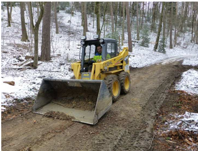
Wegen des nassen Wetters mussten nach der Holzerei zahlreiche Strassen instand gestellt werden
